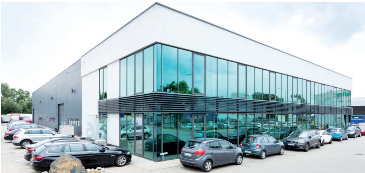
HALA MAGAZYNOWA Z ZAPLECZEM BIUROWYM LOBO Sp. z o.o. / WAREHOUSE HALL WITH OFFICE PART LOBO Sp. z o.o.
