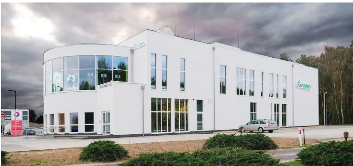
CENTRUM SPORTOWO-REKREACYJNE SPA / RECREATIONAL-SPORT CENTRE SPA
