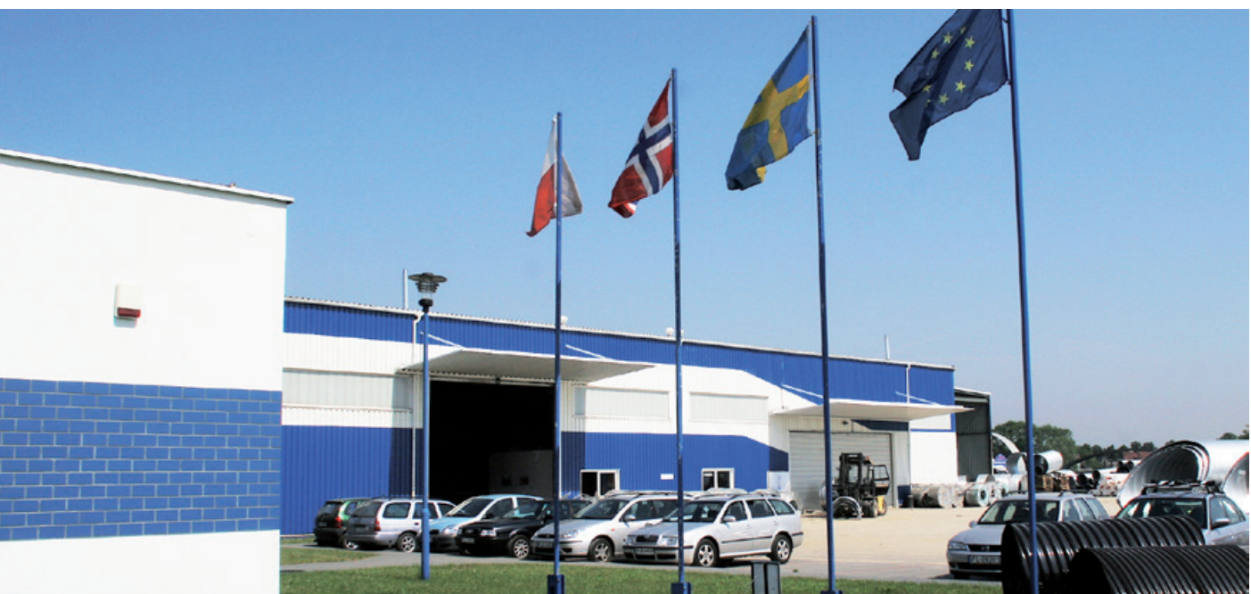
HAŁA PRODUKCYJNA WRAZ Z CZĘŚCIĄ BIUROWĄ VIACON / PRODUCTION HALL AND THE OFFICE BUILDING VIACON
