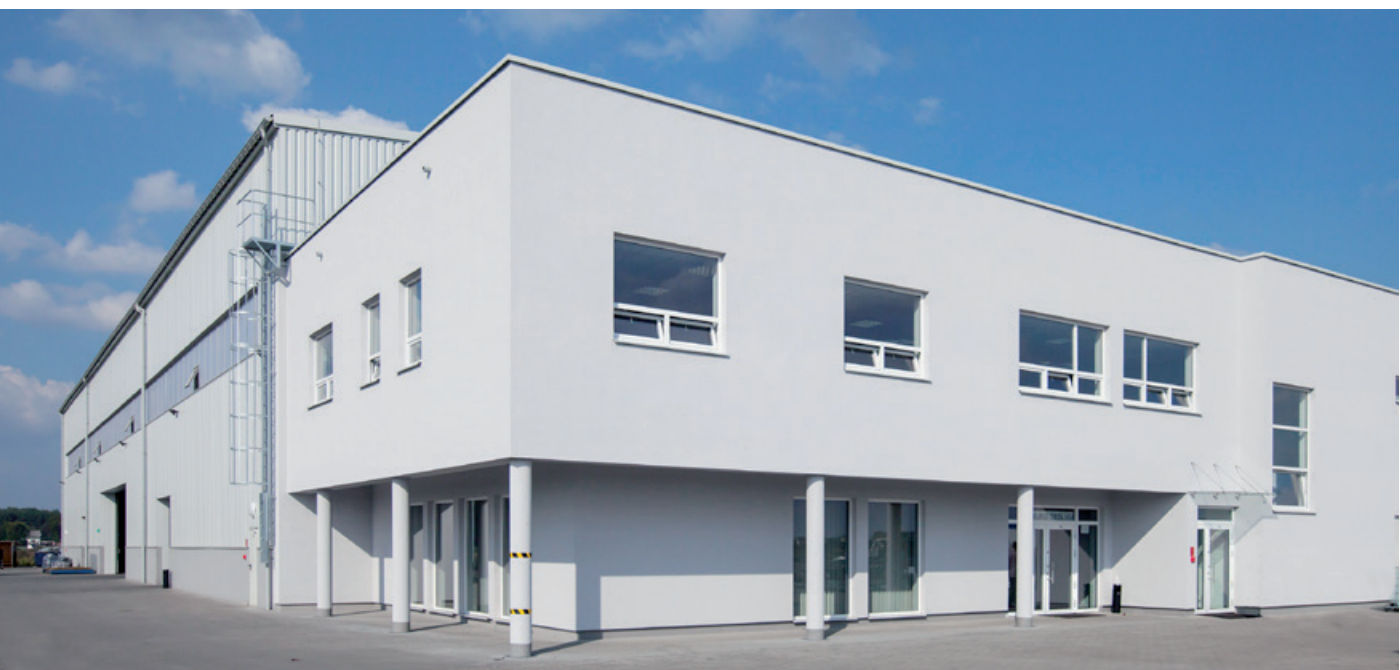
CYNKOWNIA WRAZ Z INFRASTRUKTURĄ JAMALEX / GALVANISING BUILDING WITH INFRASTRUCTURE JAMALEX
