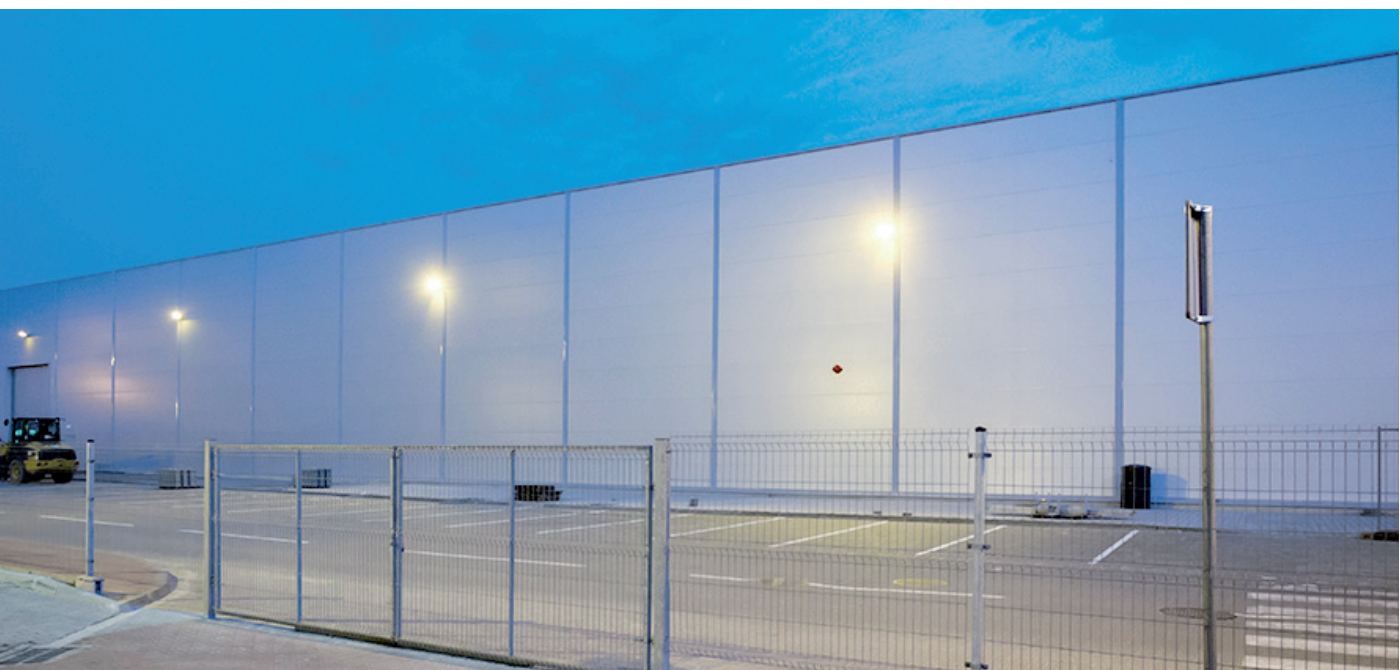
HALA PRODUKCYJNO-MAGAZYNOWA AMICA WRONKI S.A. / PRODUCTION AND WAREHOUSE HALL AMICA WRONKI S.A.
